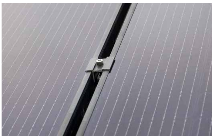
Bild 8. Mittklämma monterad.
