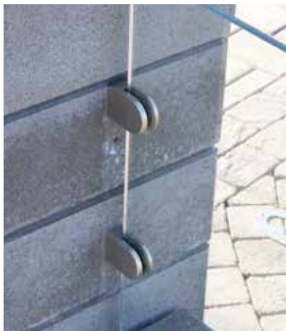
BENDER GLASSTAKET MED FÄSTEN I ROSTFRITT STÅL
